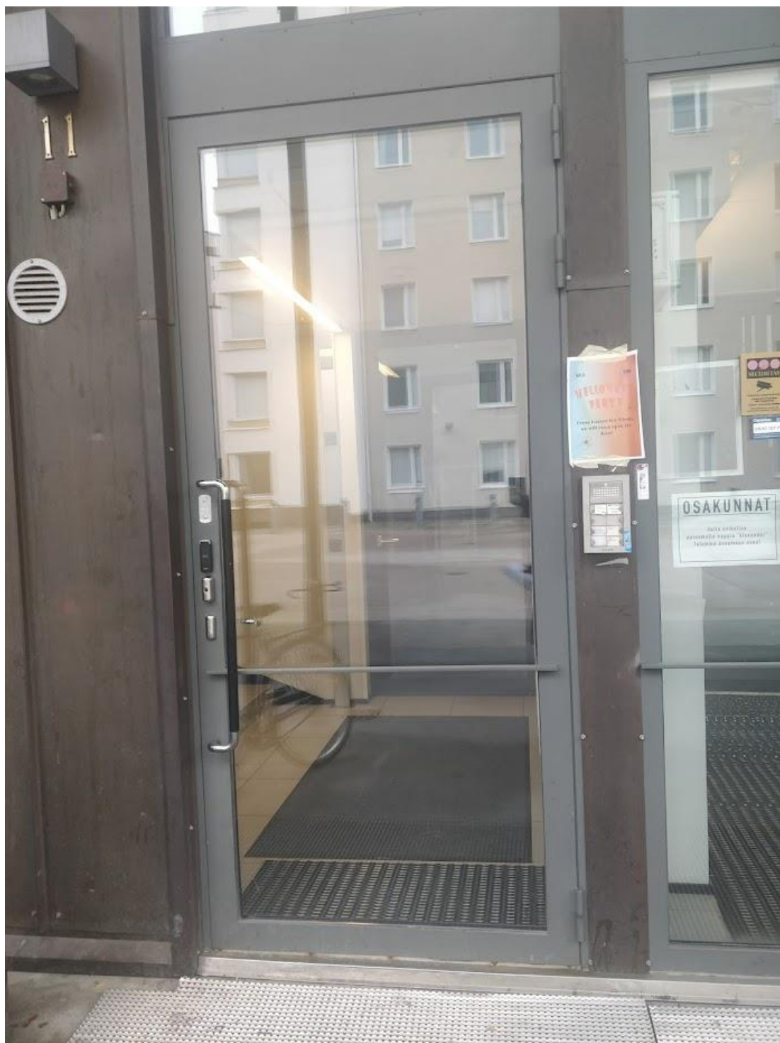
Kuva 4: Rakennuksen pääasiallinen käyntiovi, ovesta kahvan vieressä kulkuavaimenlukija (musta)
