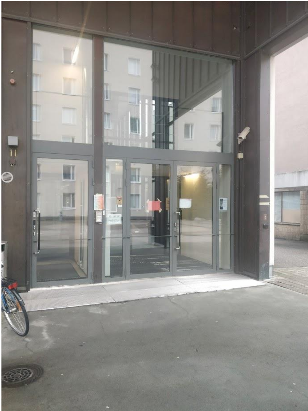
Kuva 3: Rakennuksen pääsisäänkäynti, oikealla olevissa tuplaovissa invapainike (epäkunnossa), vasemmalla pääasiallinen käyntiovi
