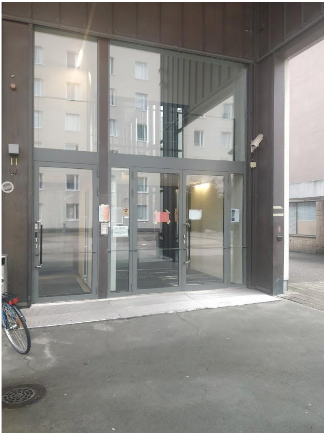
Bild 3: Huvudingång till byggnaden, den dubbla dörren till höger har en invaknapp (ur funktion), till vänster den huvudsakliga entrédörren
