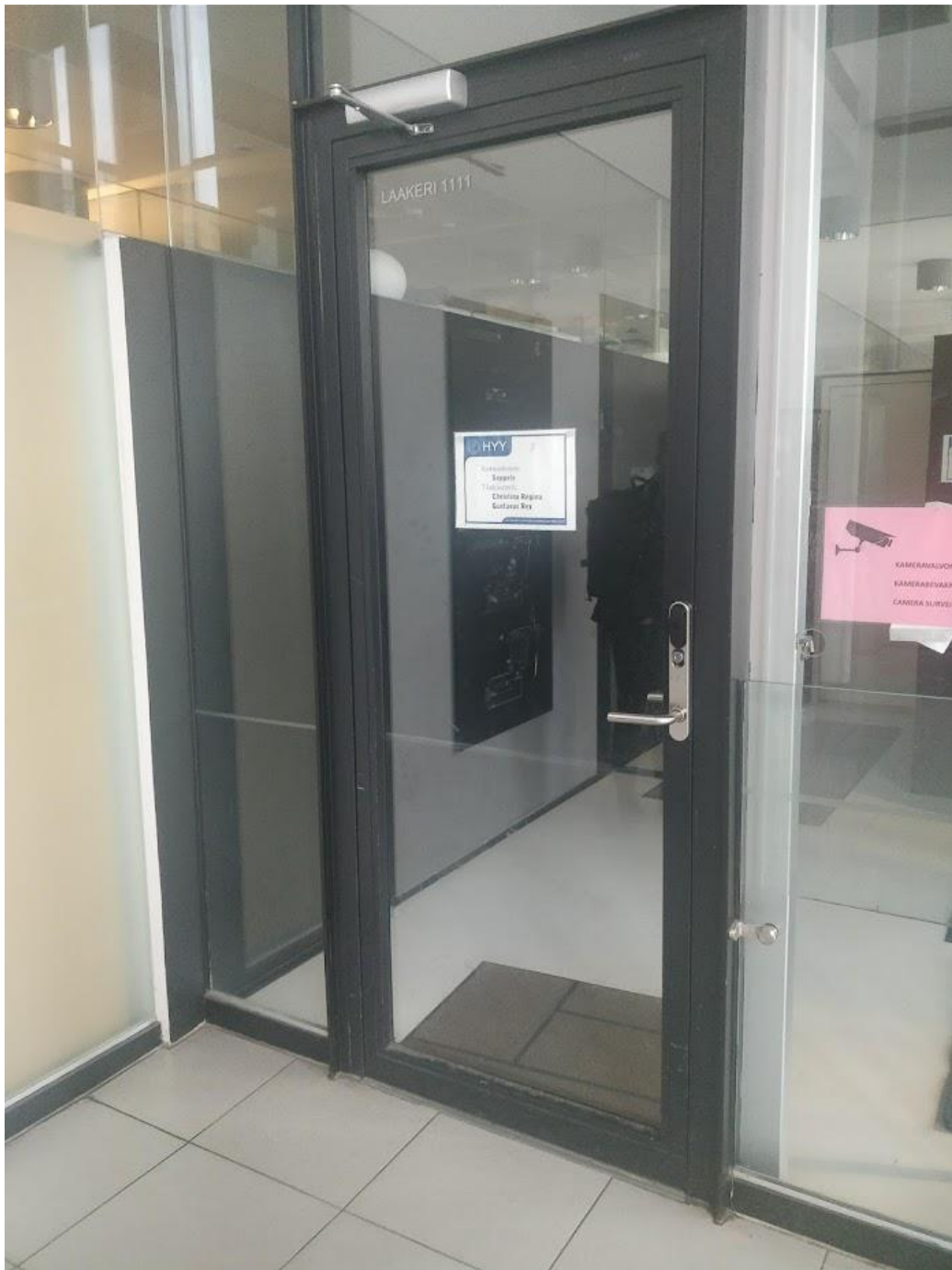
Bild 23: Dörr från entréhallen till tamburen
